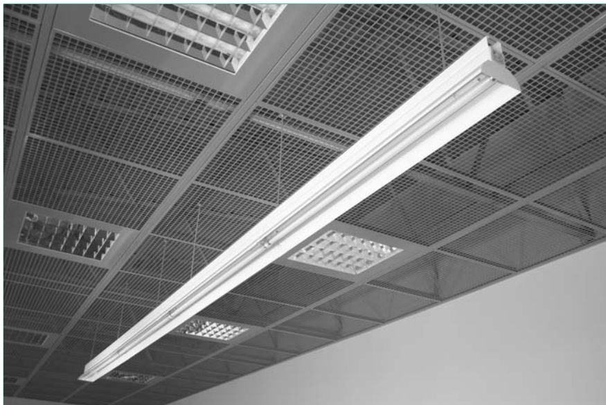
Przykład montażu odbłyśnika ODL oprawy i szyny odbłyśnika SOD
