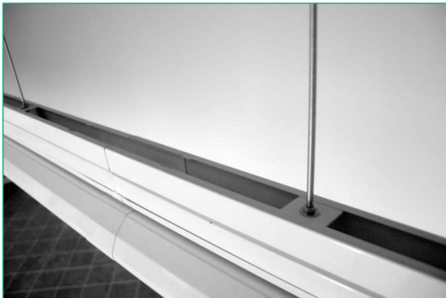
Przykład zastosowania elementu zawiesia EZ
