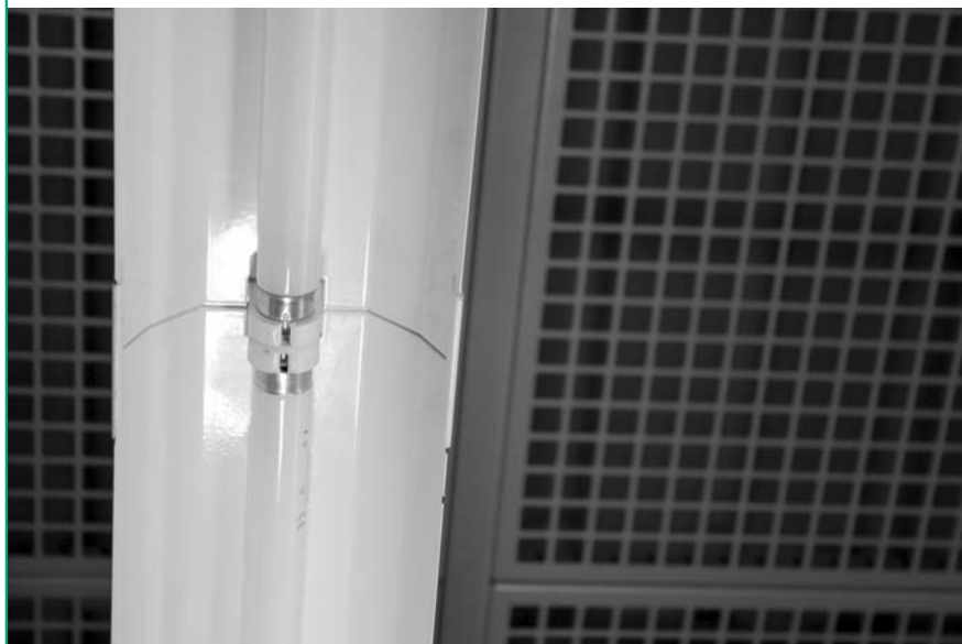
Przykład zastosowania łącznika odbłyśnika LOL
