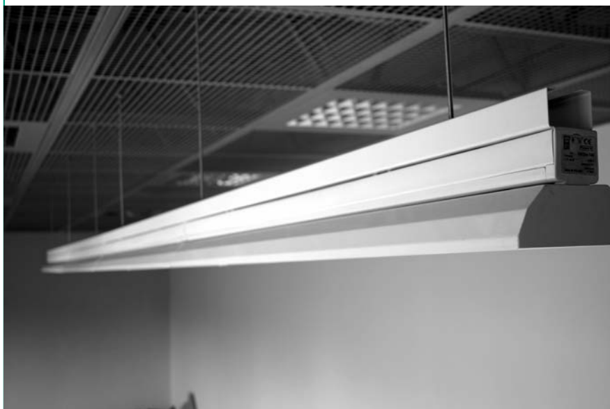
Przykład montażu odbłyśnika ODL oprawy i szyny odbłyśnika SOD
