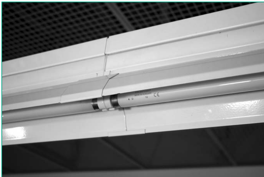
Przykład zastosowania łącznika odbłyśnika LOL
