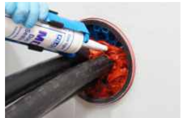
Montaż uszczelnienia przepustu zwykłego FILOseal+HD
